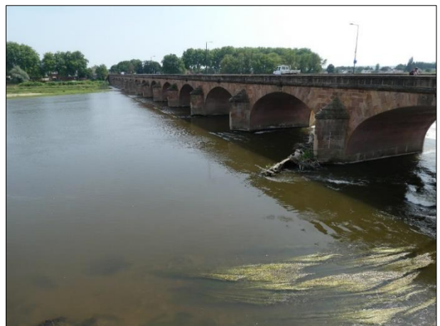
Pont de Loire, Steinbrücke über die Loire in Nevers
