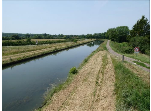
Canal du Centre bei Avril-sur-Loire
