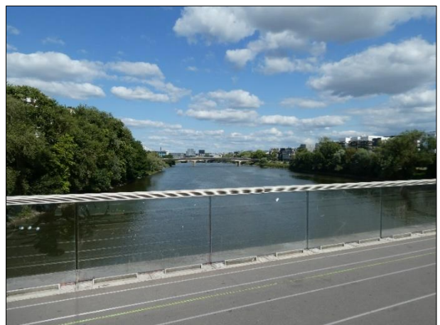
Querung der Loire über die Victor Schoelcher Brücke, Blick nach Osten
