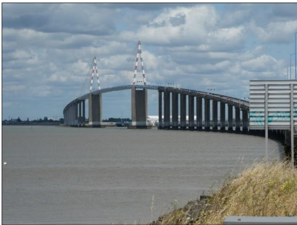
Saint-Brevin-les-Pins Brücke von Süden gesehen
