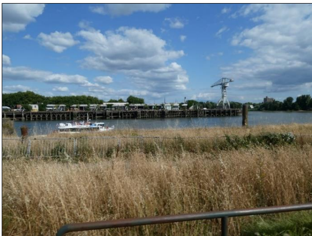
Westzipfel der Île Nantes mit dem Grue Titan Grise, heute Industriedenkmal
